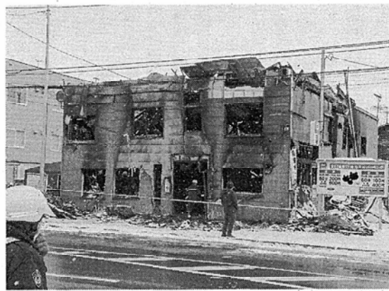
11人が亡くなる火災が発生した札幌市東区「ハイム」
